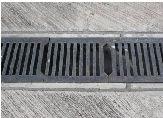
再造塑料水渠盖
