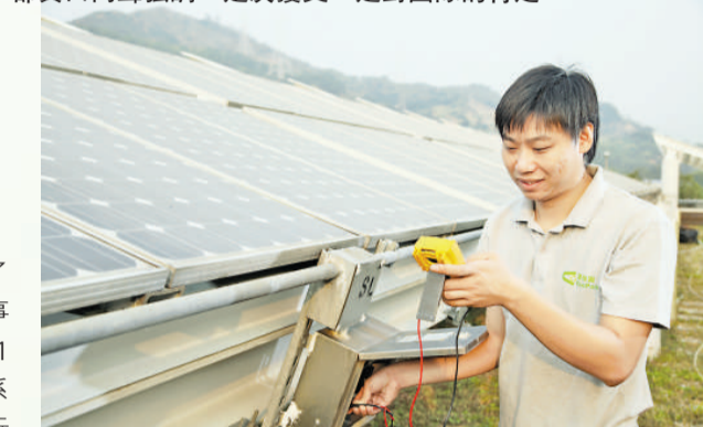
▲環保園的維修工作並不容易，因為大部分物料都是環保物料製成，必須小心處理，圖為工人在維修太陽能光伏系統設施。
